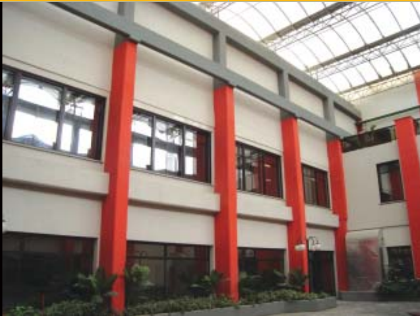
Fábrica da Votorantim Celulose e Papel, em Jacareí (SP): esquadria de aço pintado com vidro Pyran, da Schott
