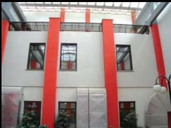
Fábrica da Votorantim Celulose e Papel, em Jacareí (SP): esquadria de aço pintado com vidro Pyran, da Schott
